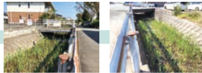
長溝団地用水路工事前
