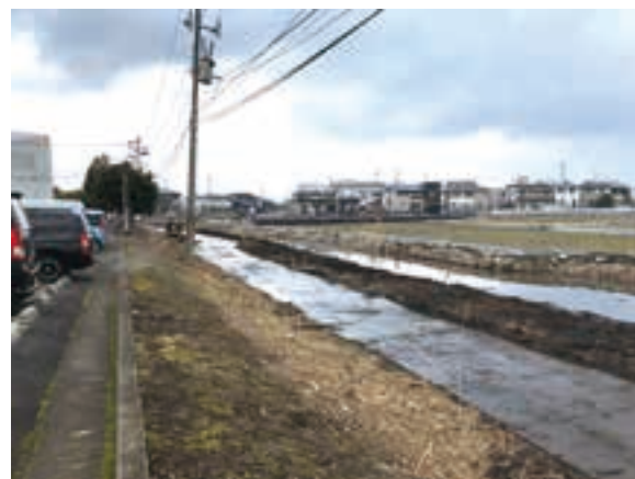
長さ240mのあふれた雨水を貯めるプールを 急遽新設
