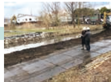
ゆめタウン裏プールの工事中
