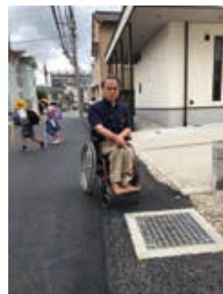
九品寺地区からの要望だった 道路舗装と排水溝が完成。 確認しました。
