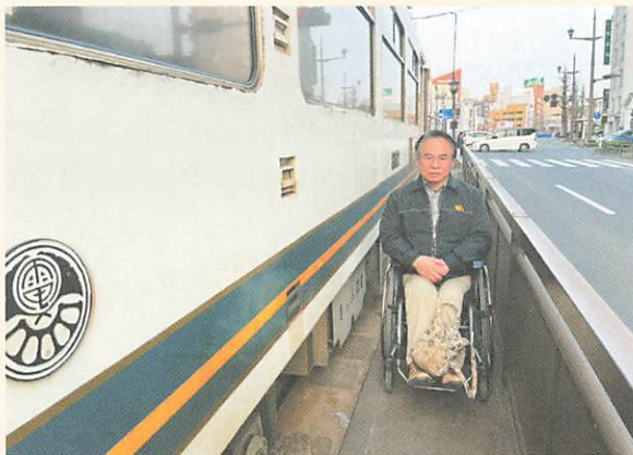
▲電停の拡幅と高さも電車と同じ高さに嵩上げされます。
