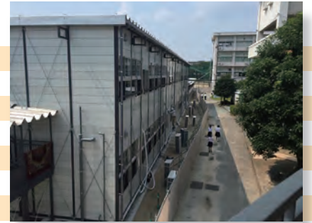
熊本高校の仮設プレハブ校舎
